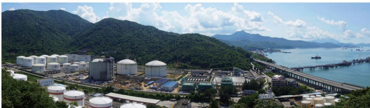
液化天然气 (Liquefied Natural Gas, 下称 LNG) 是将天然气净化处理后液化成的一种无色、无味和无毒的低温液体, 其主要成分是高纯净度的甲烷, 由于 LNG 安全性高、污染少和储运方便等特点, 被人们称为“地球上最干净的化石能源”。LNG 接收站是指对 LNG 进行接收、存储和气化外输的一种不可或缺的物流工艺设施。LNG 接收站的建设对地形环境和施工环境要求都比较高, 除了最好要分布在沿海地区, 还要满足航道、码头、水深和动力等诸多要求, 而且 LNG 海上运输是管道物流运输以外最重要的运输途径。
