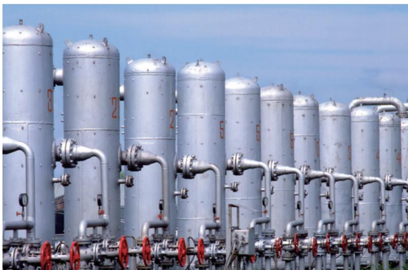
压力，使材料总体产生塑性应变，提高屈服强度，从而可以采用更薄的材料制造低温容器。
